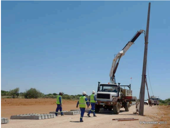
OHTE erecting
